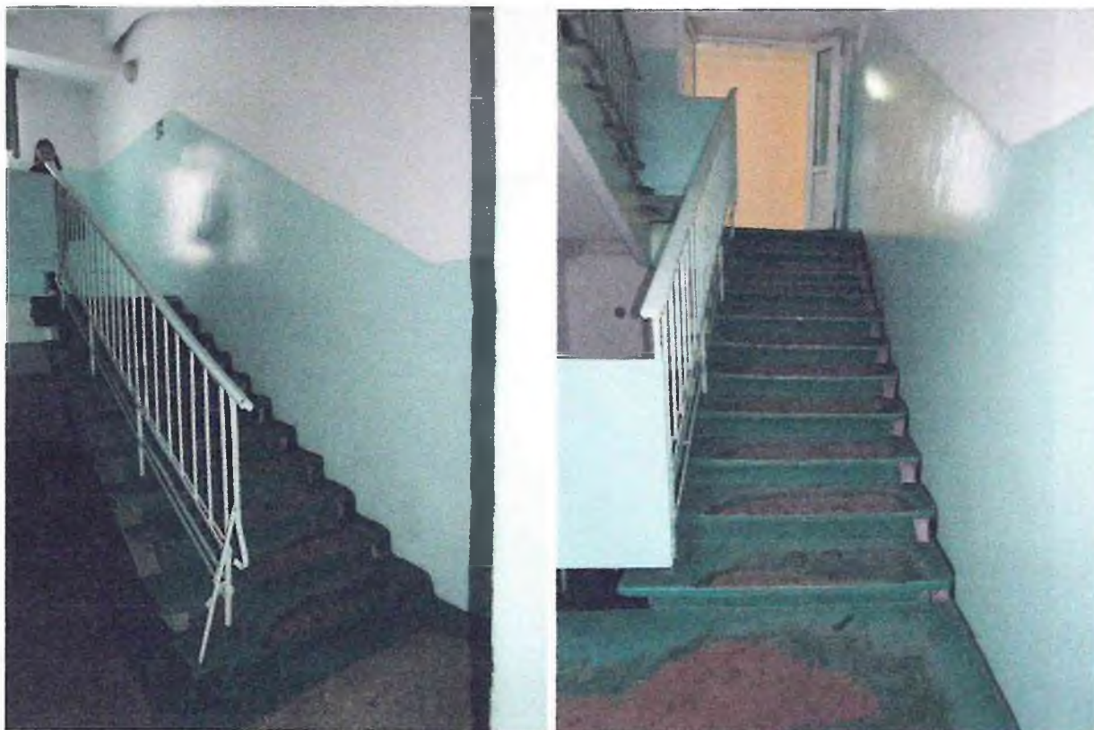
Путь (пути) движения внутри здания (в т.ч. пути эвакуации ) (фото 4)
