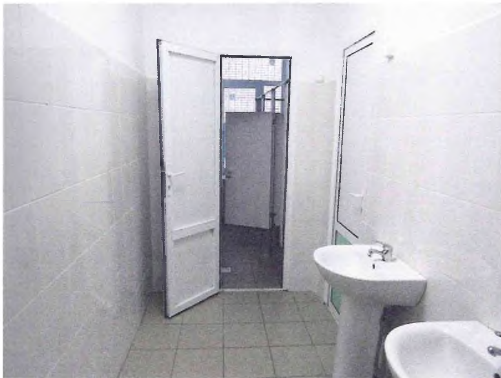
Санитарная комната на 2 этаже
